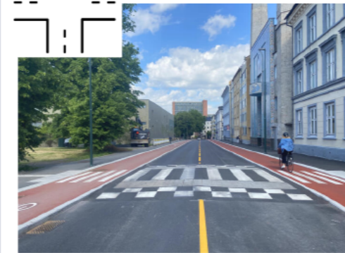
Illustrasjonsbilde: Opphøyd sykkelfelt og gangfelt i Åkebergveien. Foto: Bymiljøetaten, Oslo kommune.
