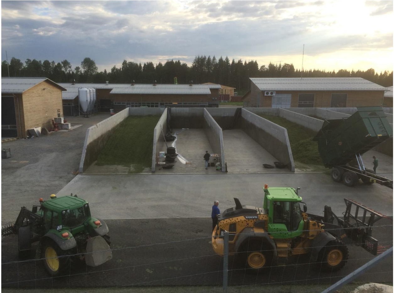
Siloanlegg med 8 plansiloer sto ferdig til 1.slåtten 2016
